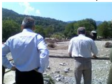
Podul și drumul distrus de ape din Valea Vișeului
